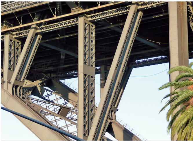
Koronkowa konstrukcja słupków i krzyżulców łuku
