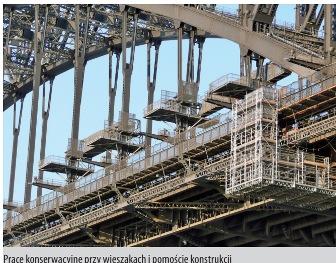
Prace konserwacyjne przy wieszakach i pomoście konstrukcji
