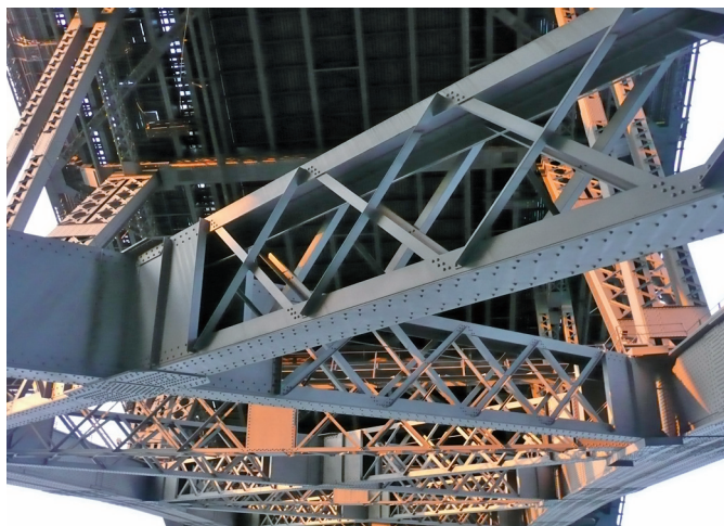
Ogrom konstrukcji stężeń poziomych przęsła łukowego
