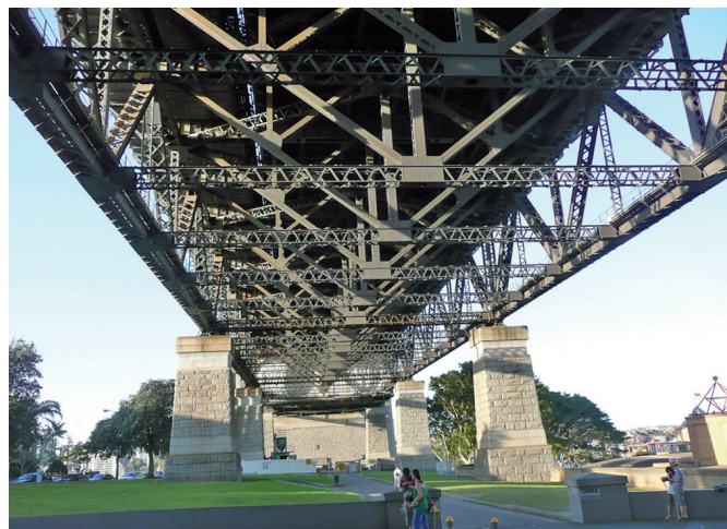
Widok konstrukcji południowej części dojazdowej od spodu
