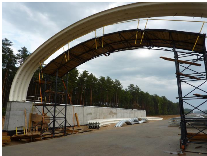
Górne przejście dla zwierząt w czasie budowy (fot. A. Wysokowski)
