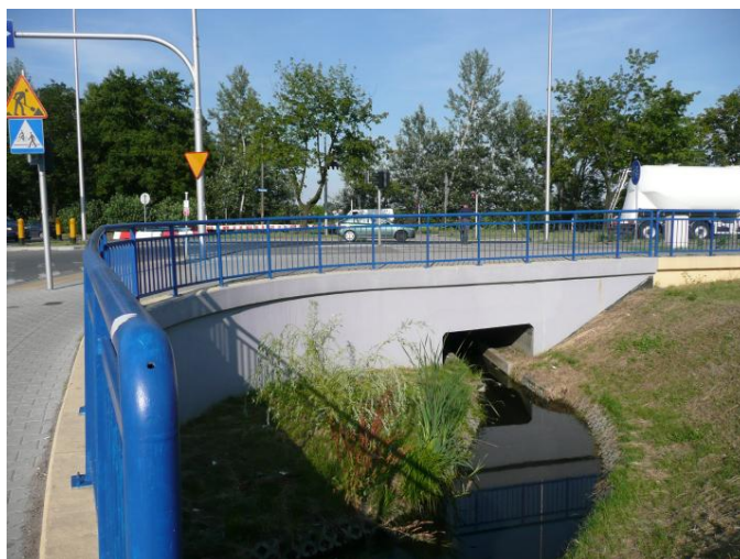
Przepust na terenie miasta (fot. J. Howis)
